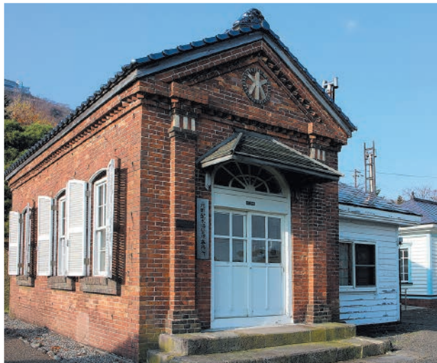
元町配水場 函館市元町1-4
