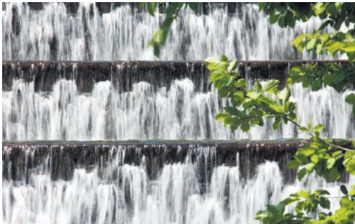
練石積（ねりいしづみ）工法で造られた階段（上）と美しい「水すだれ」（下）
