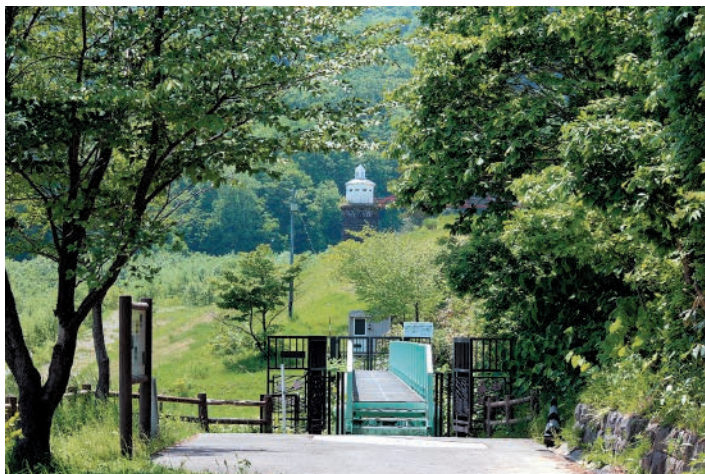
奥沢ダムの水管橋と取水塔
